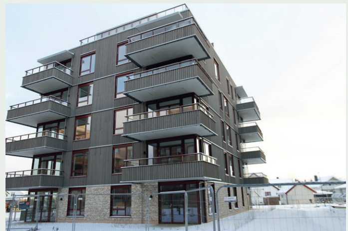
Et av de fire byggene har panelfasade.
